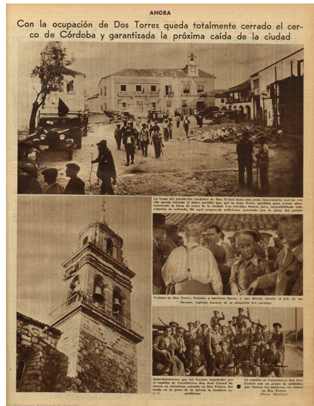
1936.08.29 Ahora. Sánchez. Toma de Dos Torres
